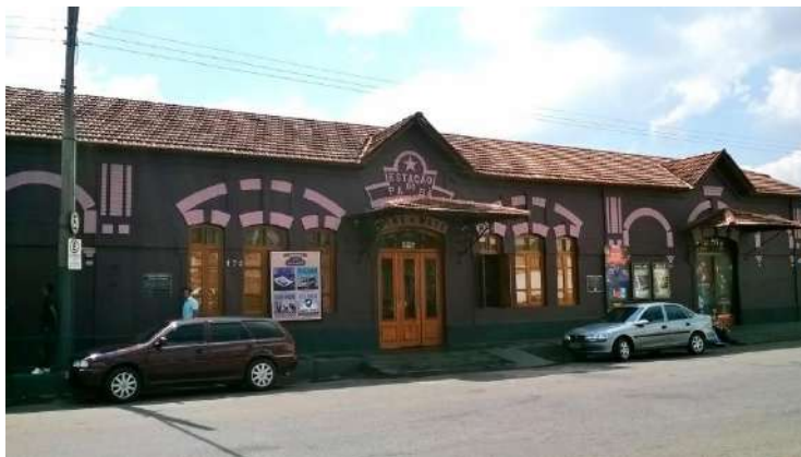
Estação Ferroviária Imagem da Internet
