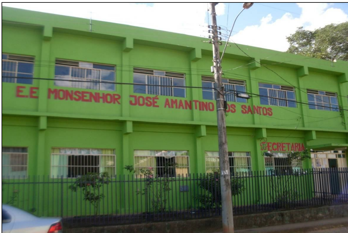
Fachada Principal da Escola. Foto: Josélia Lima, dez. de 2012
