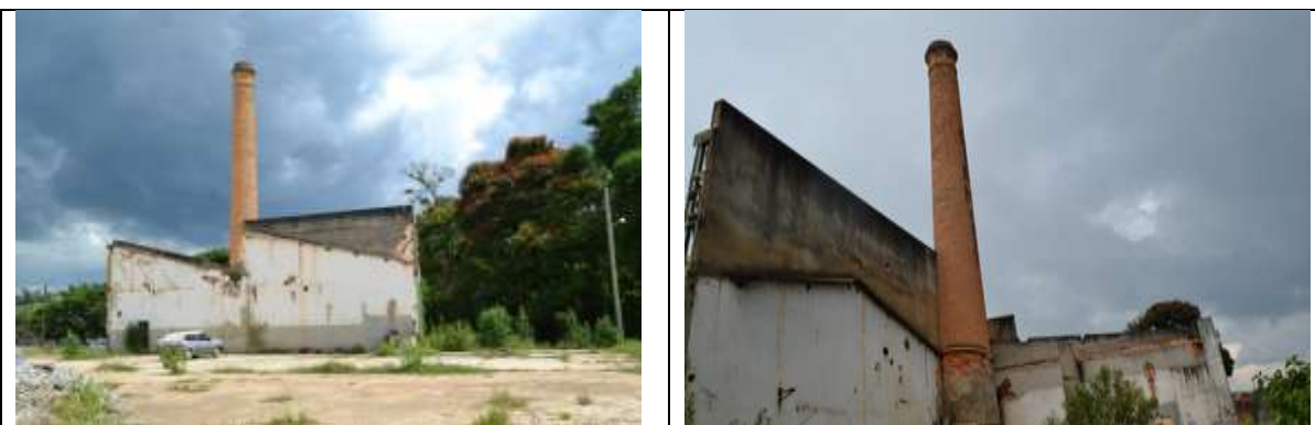
Figuras 02 e 03 – Vista da chaminé e seu entorno.
