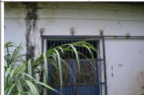
Figuras 41 e 42 – Fachada frontal da casa de máquinas, com manchas de umidade
