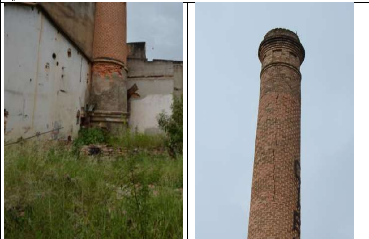
Figura 04 – Descolamento de reboco e vegetação junto a base.
