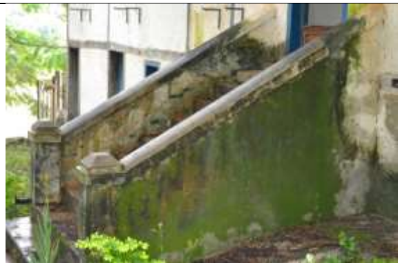
Figura 30 – Escada de acesso a varanda.
