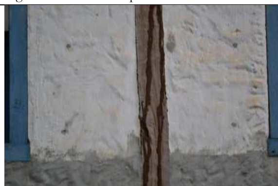
Figura 36 – Presença de cupins de solo.
