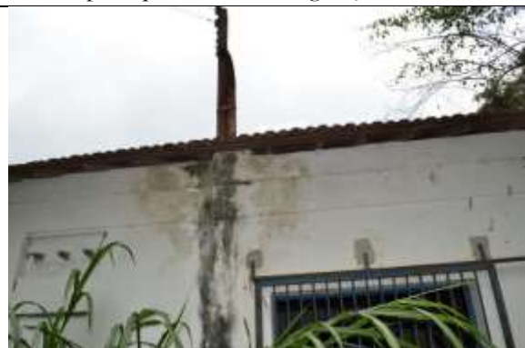
Figuras 41 e 42 – Fachada frontal da casa de máquinas, com manchas de umidade
