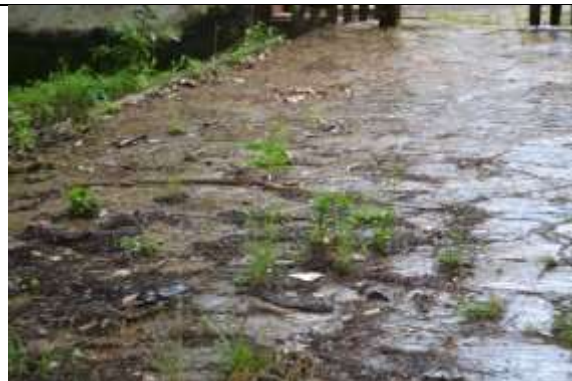
Figura 29 – Piso em pedras no acesso principal.
