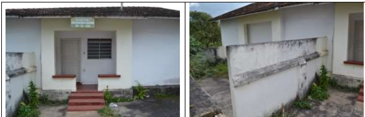
Figuras 44 e 45 – Vista interna ao muro na parte frontal da Corporação Musical.
