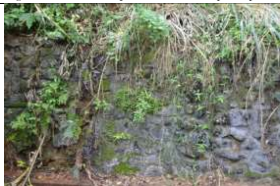
Figura 31 – Muro de pedras externo.
