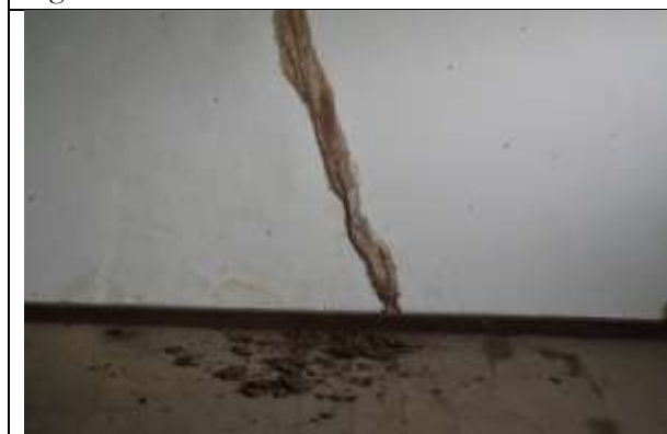
Figura 25 – Presença de cupins de solo.
