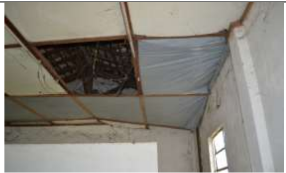
Figura 17 – Forro danificado.
