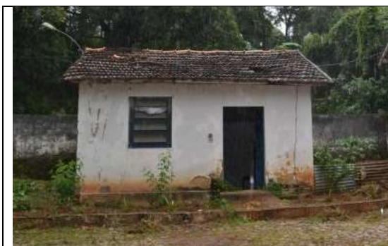
Figura 06 – Vista da fachada frontal da Casa do Poço Artesiano
