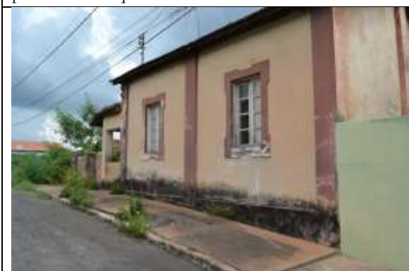
Figura 48 – Edificação remanescente da margem direita da rua Nossa Senhora da Saúde.
