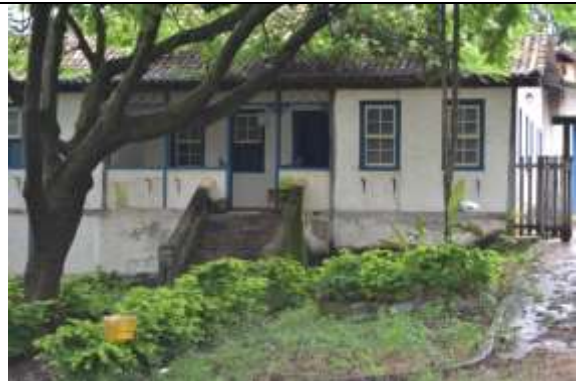
Figura 28 – Detalhe da varanda
