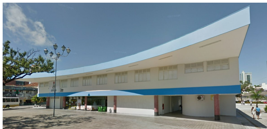
IMAGEM FRONTAL EDIFICAÇÃO PAS-S_N-05 - ANTIGA RODOVIÁRIA - RUA DR. BARATA (NOV. DE 2011)
