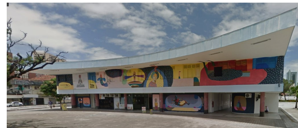
IMAGEM FRONTAL EDIFICAÇÃO PAS-S_N-05 - ANTIGA RODOVIÁRIA - RUA DR. BARATA (SET. DE 2019)
