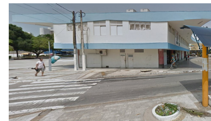
IMAGEM LATERAL DIREITA EDIFICAÇÃO PAS-S_N-05 - ANTIGA RODOVIÁRIA RUA SACHET (AGO. DE 2015)
