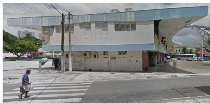
IMAGEM LATERAL DIREITA EDIFICAÇÃO PAS-S_N-05 - ANTIGA RODOVIÁRIA RUA SACHET (SET. DE 2019)
