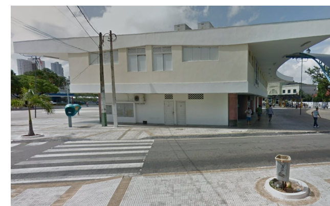
IMAGEM LATERAL DIREITA EDIFICAÇÃO PAS-S_N-05 - ANTIGA RODOVIÁRIA RUA SACHET (NOV. DE 2011)
