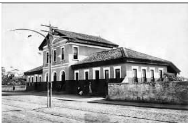
Estação Ferroviária Central de Natal
