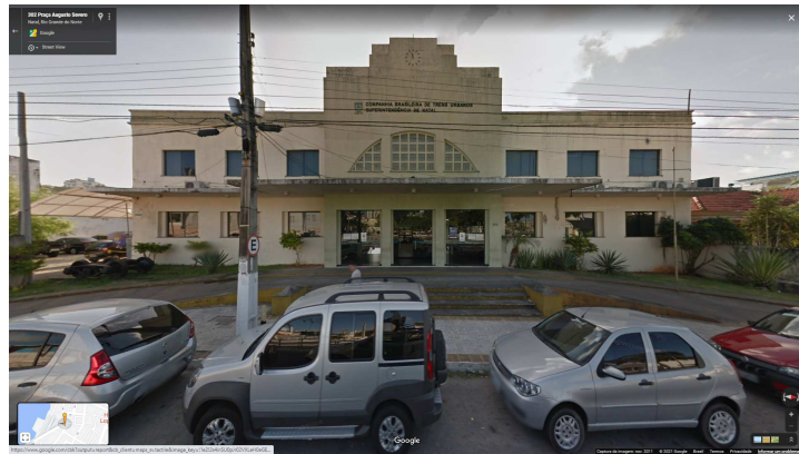
IMAGEM FRONTAL EDIFICAÇÃO PAS-CBTU (NOV. DE 2011)
