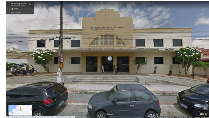
IMAGEM FRONTAL EDIFICAÇÃO PAS-CBTU (AGO. DE 2019)
