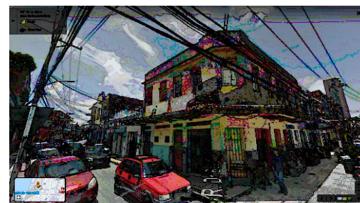
IMAGEM LATERAL EDIFICAÇÃO PAS-79 (MAR. DE 2017)
