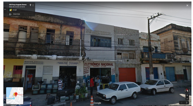
IMAGEM FRONTAL EDIFICAÇÃO PAS-81-B (JUL. DE 2014)
