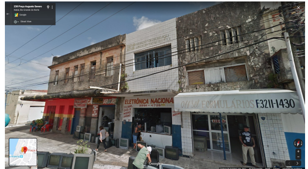
IMAGEM FRONTAL EDIFICAÇÃO PAS-81-B (NOV. DE 2011)
