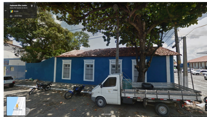
IMAGEM LATERAL EDIFICAÇÃO RC-01 (MAR. DE 2017)
