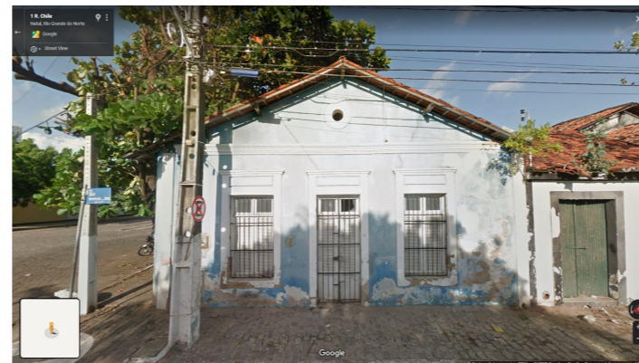
IMAGEM FRONTAL EDIFICAÇÃO RC-01 (JUN. DE 2016)
