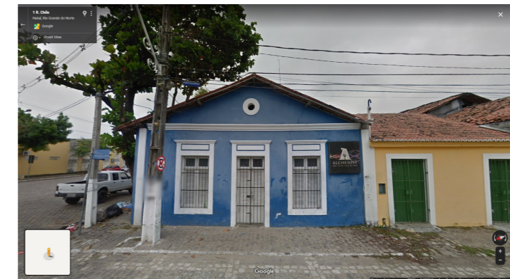
IMAGEM FRONTAL EDIFICAÇÃO RC-01 (AGO. DE 2019)
