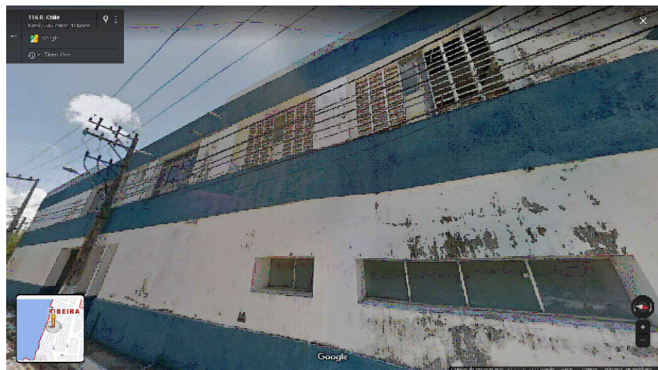
IMAGEM LATERAL EDIFICAÇÃO RC-128 (NOV. DE 2011)
