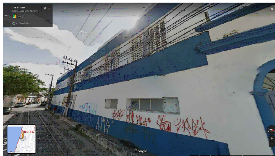
IMAGEM LATERAL EDIFICAÇÃO RC-128 (DEZ. DE 2014)
