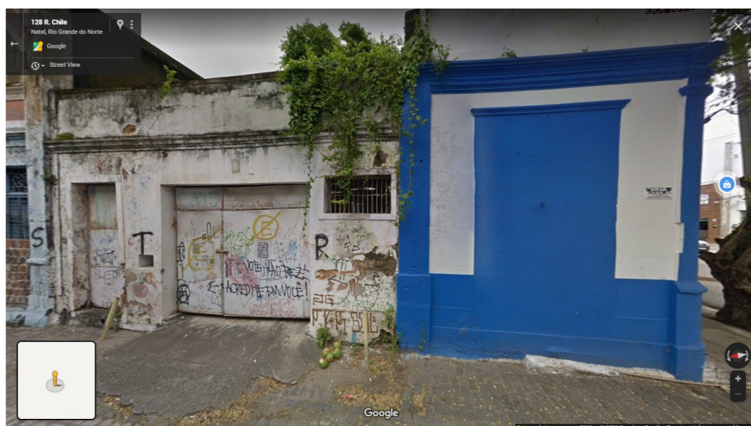
IMAGEM FRONTAL EDIFICAÇÃO RC- 133 (AGO. DE 2019)
