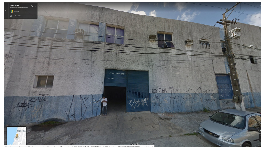
IMAGEM FRONTAL EDIFICAÇÃO RC-164 (JUN. DE 2016)
