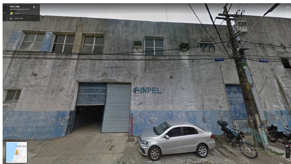
IMAGEM FRONTAL EDIFICAÇÃO RC-164 (AGO. DE 2019)
