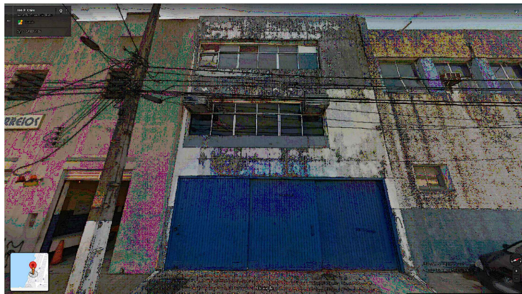
IMAGEM FRONTAL EDIFICAÇÃO RC-172 (NOV. DE 2011)
