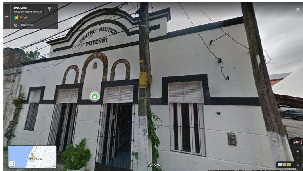
IMAGEM FRONTAL EDIFICAÇÃO RC- 38 (AGO. DE 2019)
