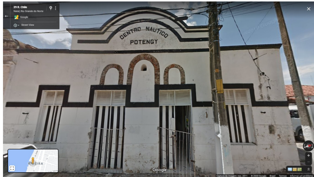
IMAGEM FRONTAL EDIFICAÇÃO RC- 38 (NOV. DE 2011)
