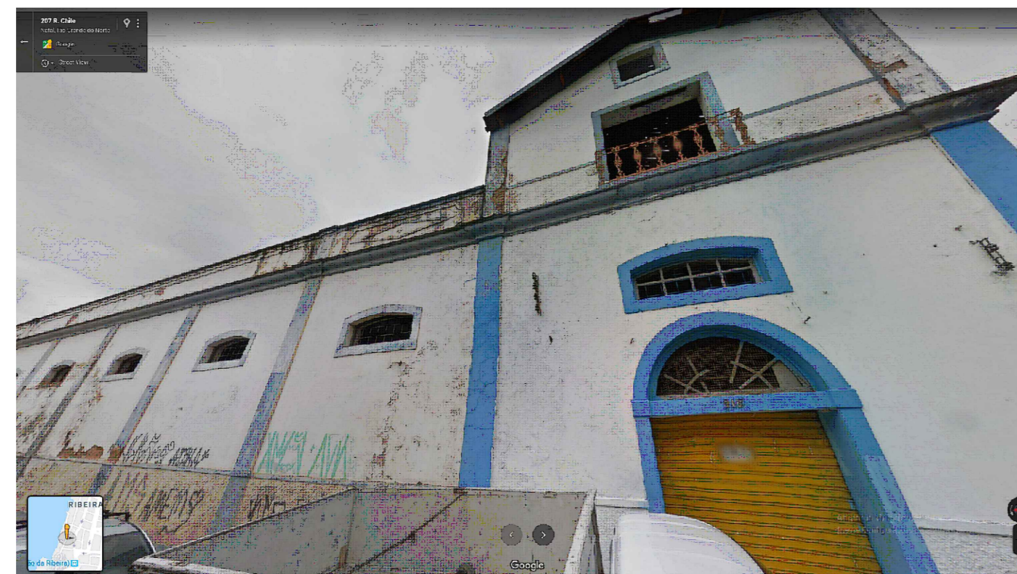
IMAGEM FRONTAL EDIFICAÇÃO RC-203 (AGO. DE 2019)
