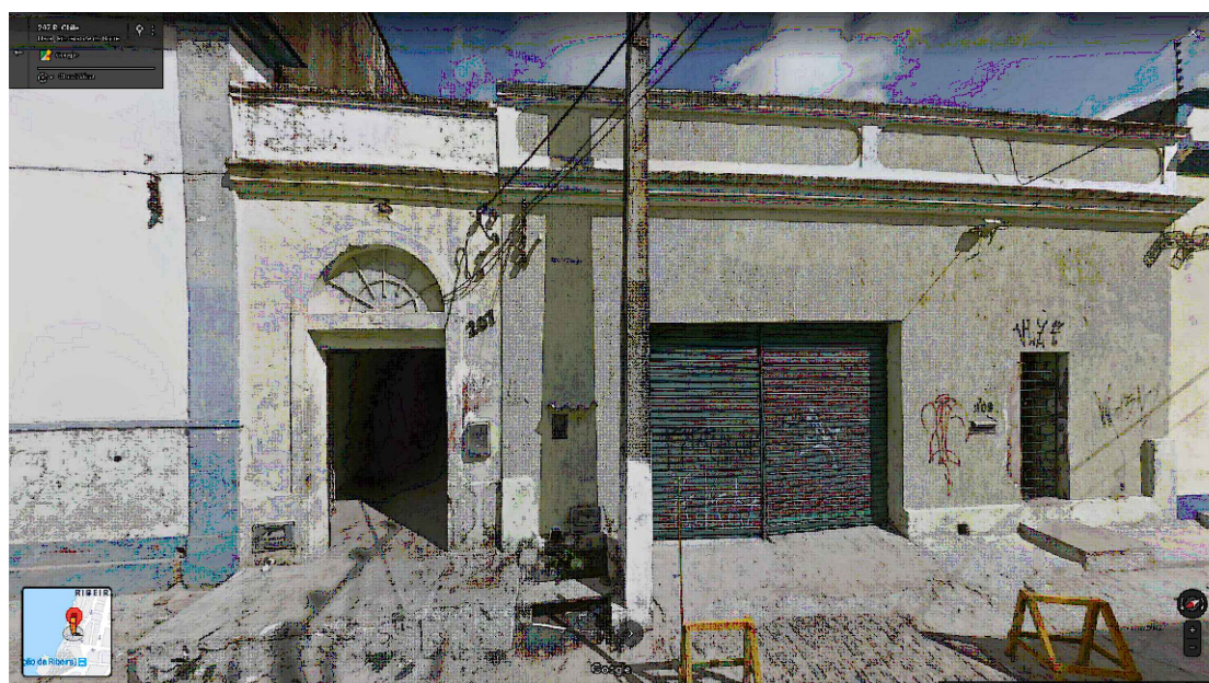
IMAGEM FRONTAL EDIFICAÇÃO RC-209 (JUN. DE 2016)
