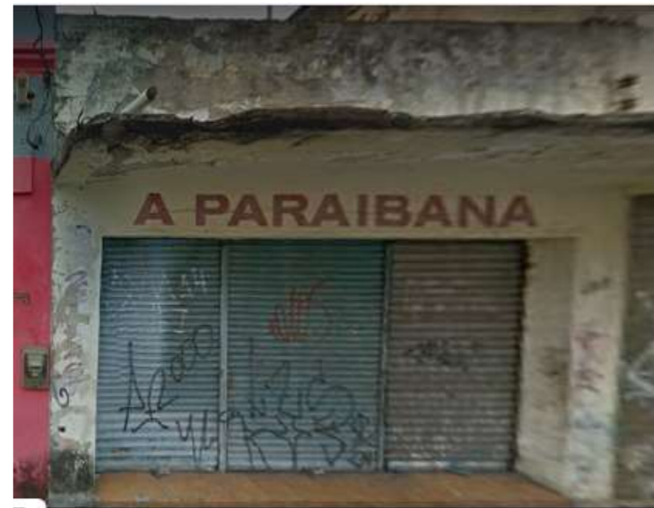
IMAGEM FRONTAL EDIFICAÇÃO RDB - 197 (AGO. DE 2019)
