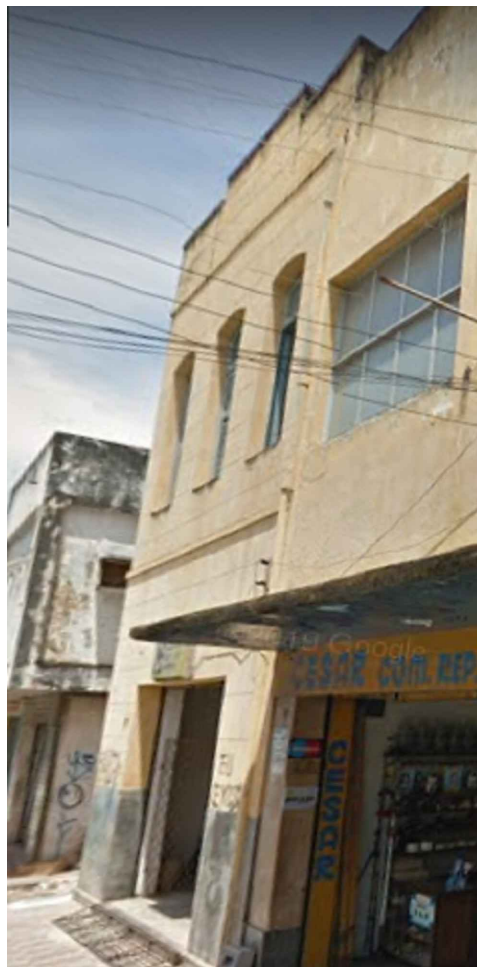
IMAGEM FRONTAL EDIFICAÇÃO RDB - 205 (NOV. DE 2011)
