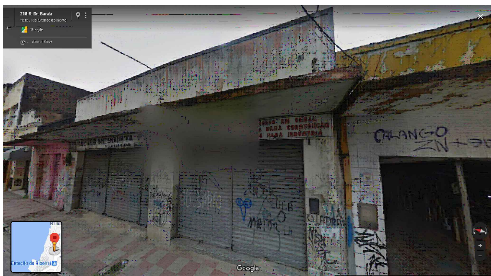
IMAGEM FRONTAL EDIFICAÇÃO RDB-217 (AGO. DE 2019)
