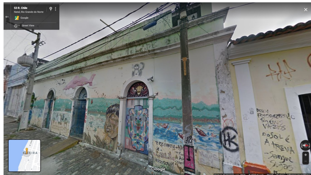
IMAGEM FRONTAL EDIFICAÇÃO RC- 48 (AGO. DE 2019)
