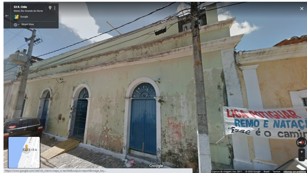
IMAGEM FRONTAL EDIFICAÇÃO RC- 48 (NOV. DE 2011)
