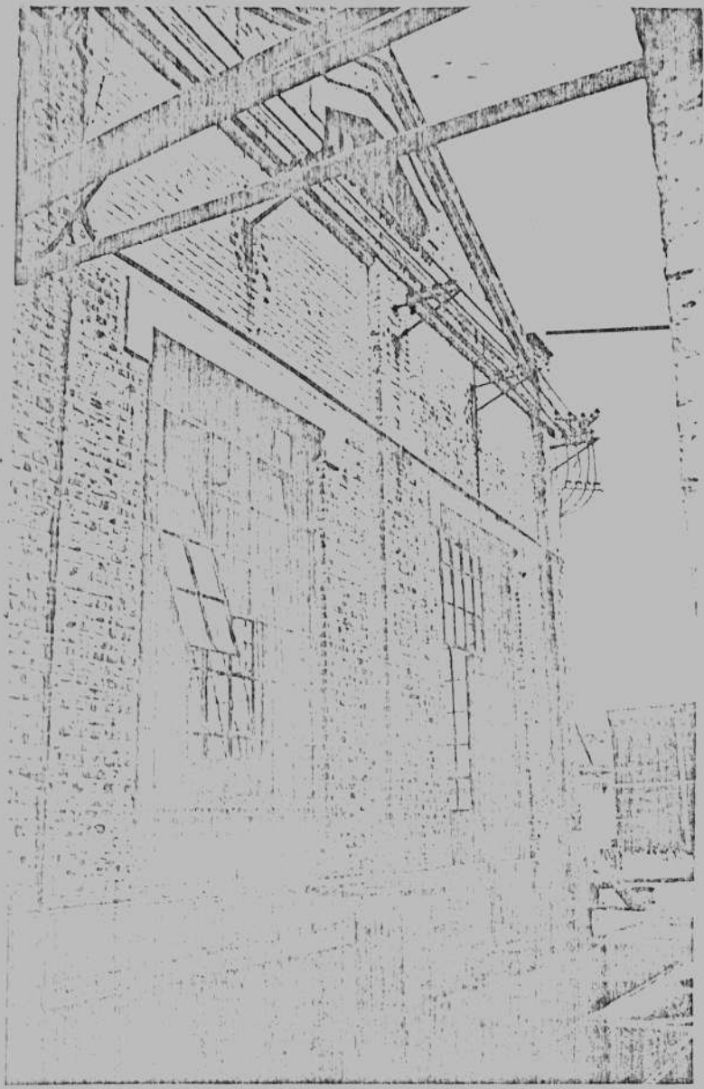
CASA DOS COMPRESSORES
