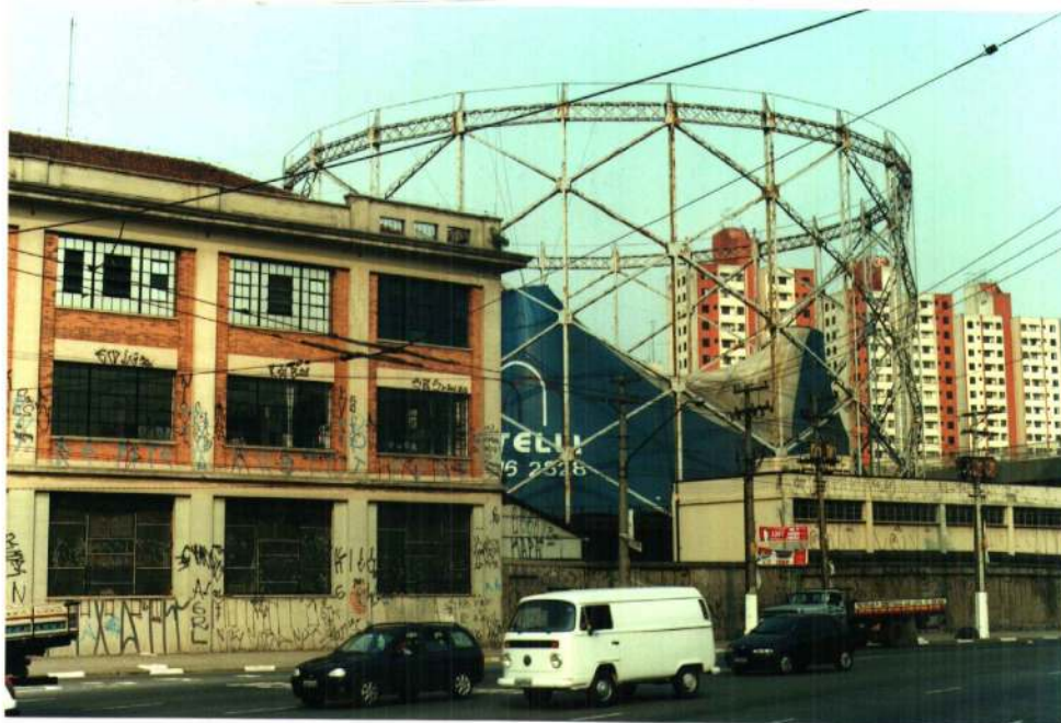
Gasômetro do Brás: escada externa - Edifício Administrativo – ao fundo Estrutura do segundo balão
