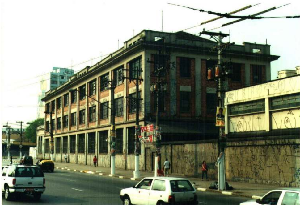
Gasômetro do Brás: Edifício Administrativo Visto a partir do Pque. D. Pedro. Foto: STCR/ Condephaat Arqto. Sergio De Simone
