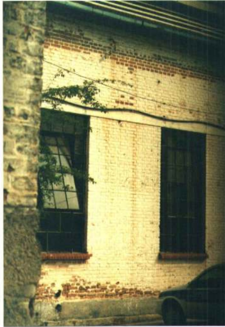
Gasômetro do Brás: Casa de compressores – aspectos Externos. Foto: STCR/ Condephaat Arqto. Sergio De Simone
