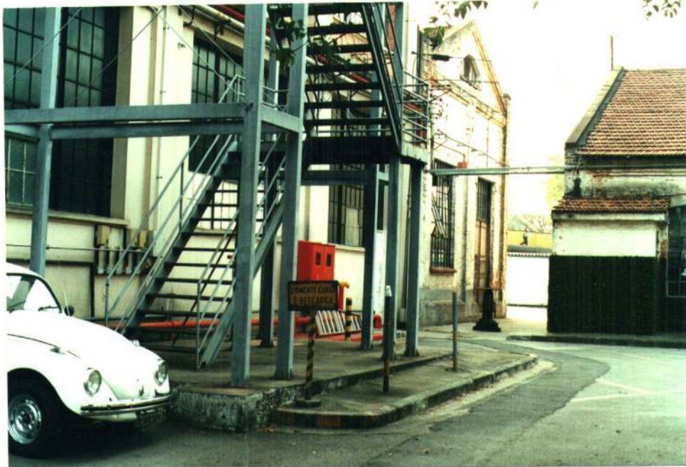
Gasômetro do Brás: escada externa - Edifício Administrativo – ao fundo , à esquerda, casa de compressores e à direita casa de medidores Foto: STCR/ Condephaat Arqto. Sergio De Simone Data: 18/09/2002.
