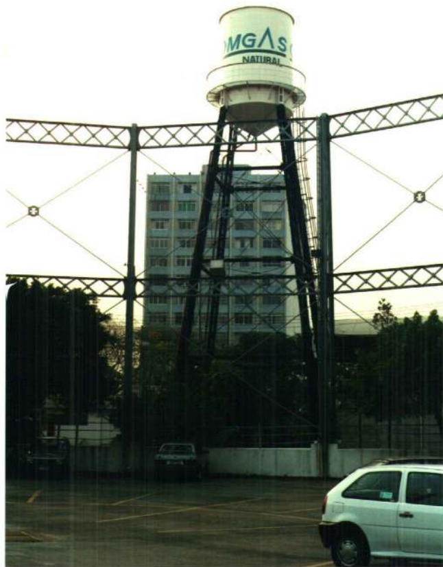
Gasômetro do Brás: Caixa D'água e parte da estrutura do primeiro balão.
