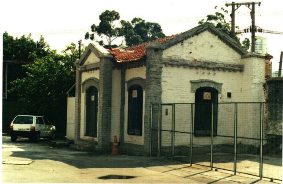
s Gasômetro do Brás: Casa das Retortas Edícula Vistoria: Condephaat/STCR – out/2002 Fotos: Arqto. Sergio De Simone
