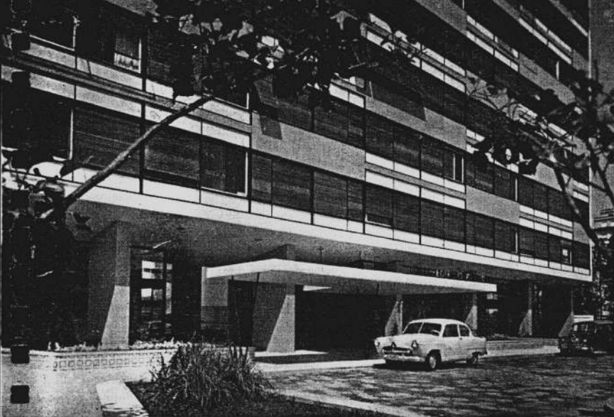
Vista da entrada principal do Edifício "Paulicéia". Fachada revestida de pastilhas. Persianas de enrolar de madeira, envernizada.
