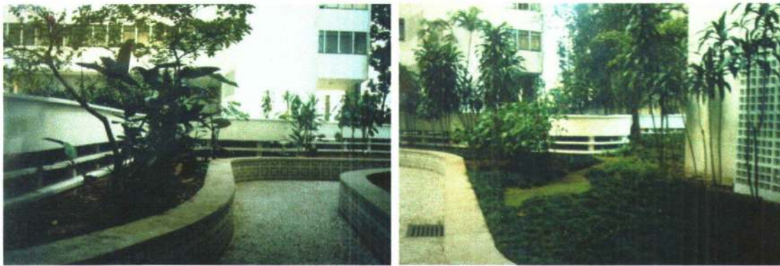
VISTA POSTERIOR DO EDIFÍCIO SÃO CARLOS DO PINHAL, LATERAL DIREITA / EM EVIDÊNCIA, O DETALHE DE VENTILAÇÃO DA GARAGEM E O ELEMENTO VAZADO NO ACESSO DE SERVIÇO DO EDIFÍCIO PAULICÉIA.
