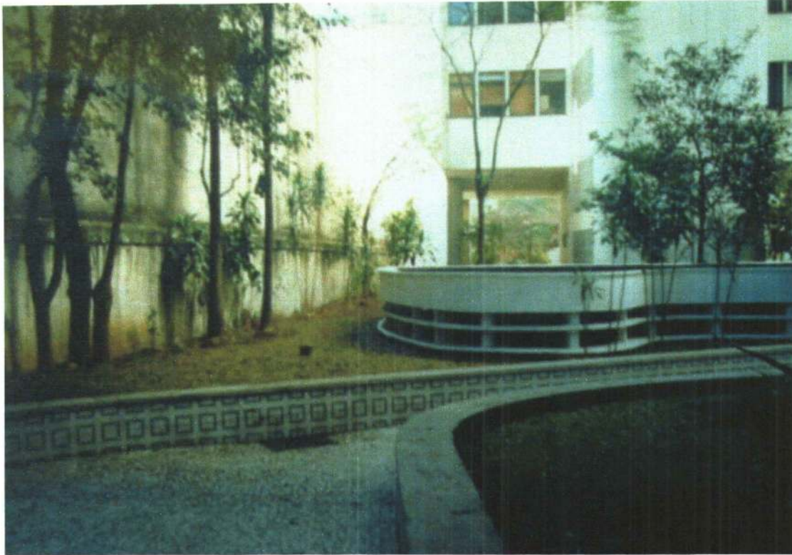
ESPAÇO ENTRE OS EDIFÍCIOS GÊMEOS / VISTA PARA A SÃO CARLOS DO PINHAL, LATERAL ESQUERDA / EM EVIDÊNCIA OS DETALHES DO SISTEMA DE VENTILAÇÃO DO SUBSOLO (GARAGEM), DO MOSAICO PORTUGUÊS NO PISO E A TORRE DE CIRCULAÇÃO VERTICAL.
