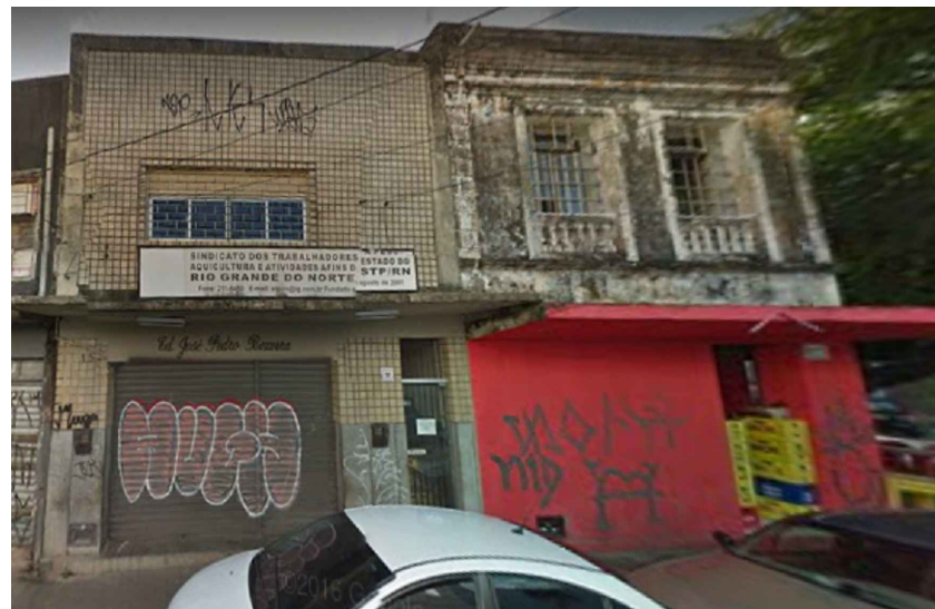
IMAGEM FRONTAL EDIFICAÇÃO RDB-158 (DEZ. DE 2014)
