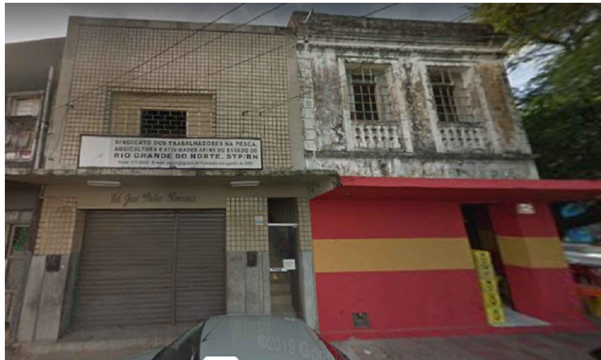
IMAGEM FRONTAL EDIFICAÇÃO RDB-158 (NOV. DE 2011)
